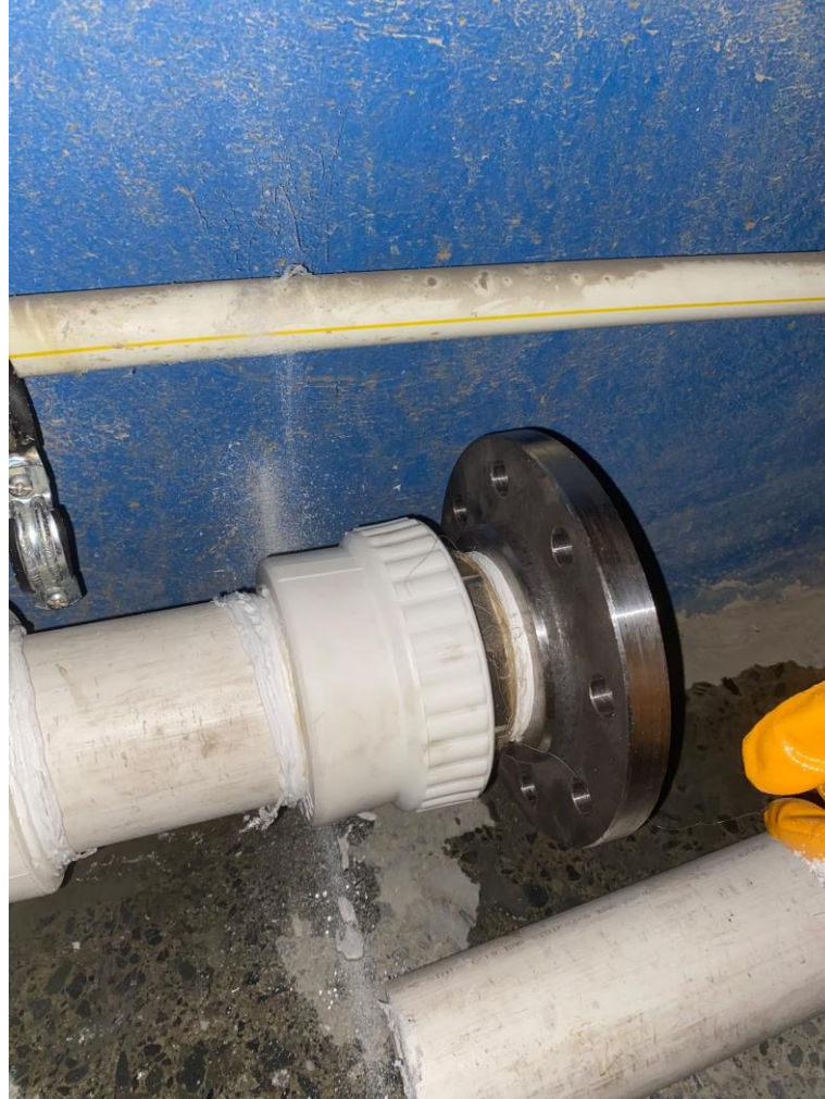
Yumuşatma sistemi tahliye gideri için süzme sayaç yeri yapılmıştır.
