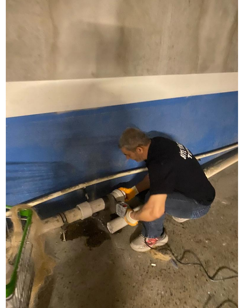
Yumuşatma sistemi tahliye gideri için süzme sayaç yeri yapılmıştır.
