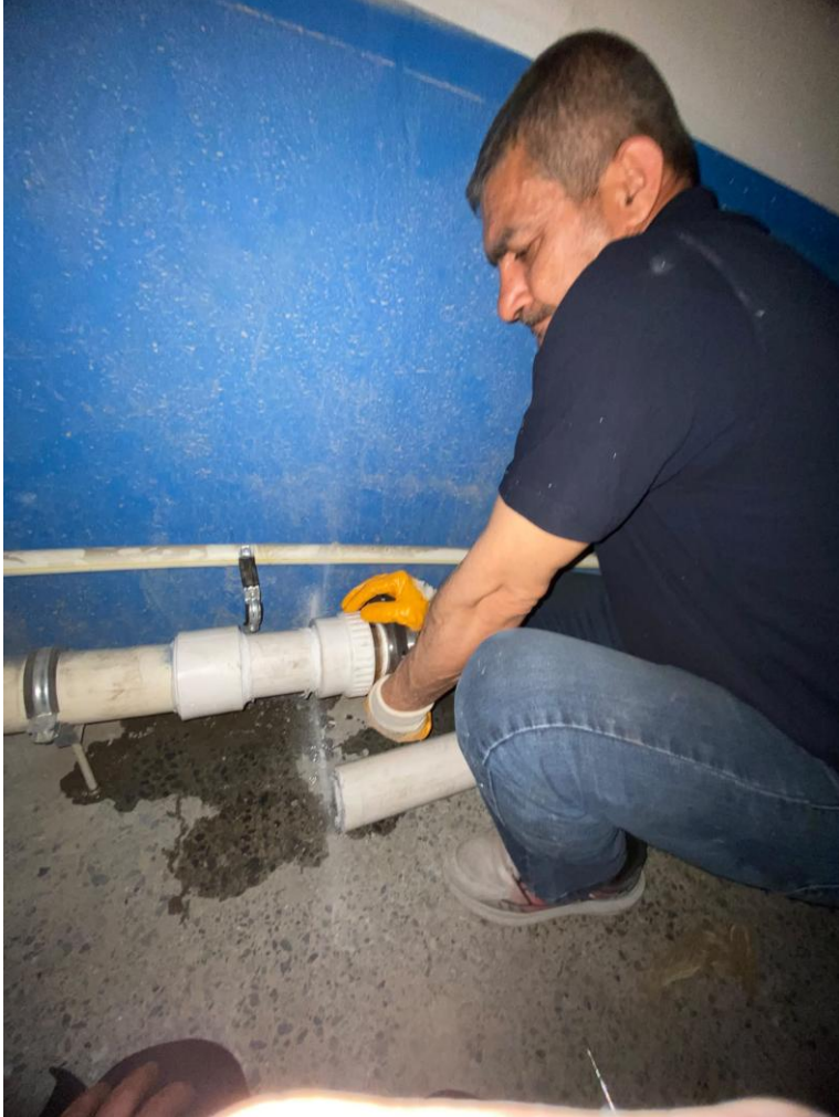
Yumuşatma sistemi tahliye gideri için süzme sayaç yeri yapılmıştır.
